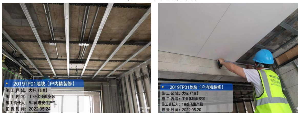
图 3 装配式吊顶现场安装图
