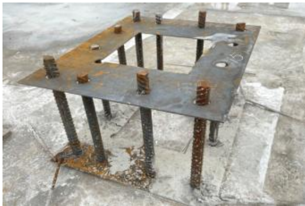
图 8 双层定位钢板限位校准现场图
