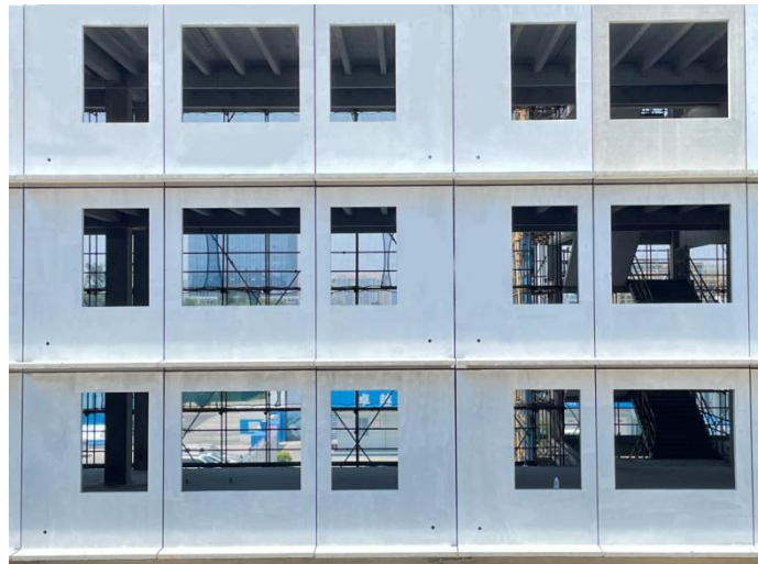
图 11 预制外墙板现场图
