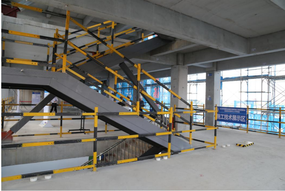
图 13 主体结构验收实景
