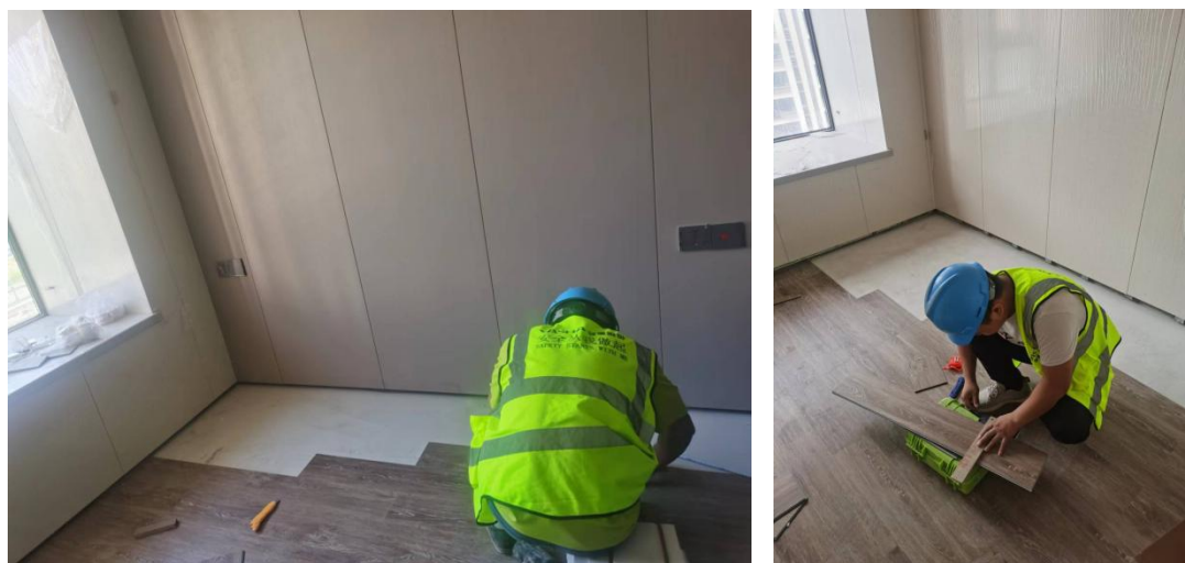
图6 装配式地面安装顺序
