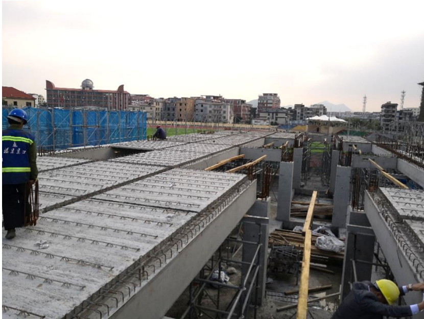
图 2 全装配混凝土框架体系现场图
