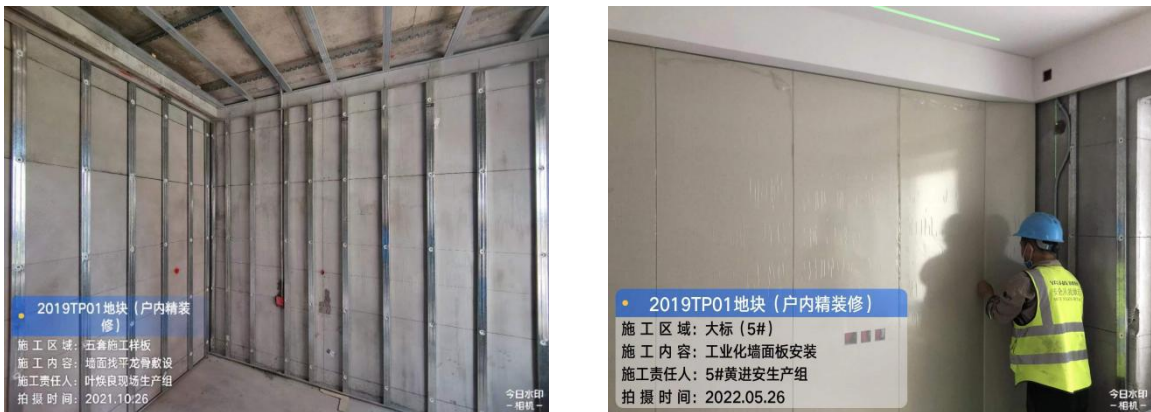
图 5 装配式墙面现场安装图
