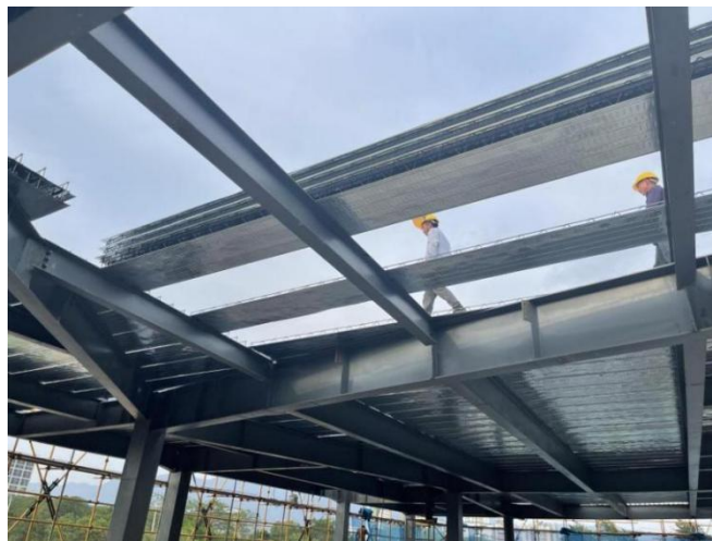
图 3 钢筋桁架楼承板
