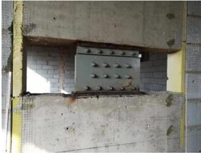
图 2 摩擦型阻尼器
