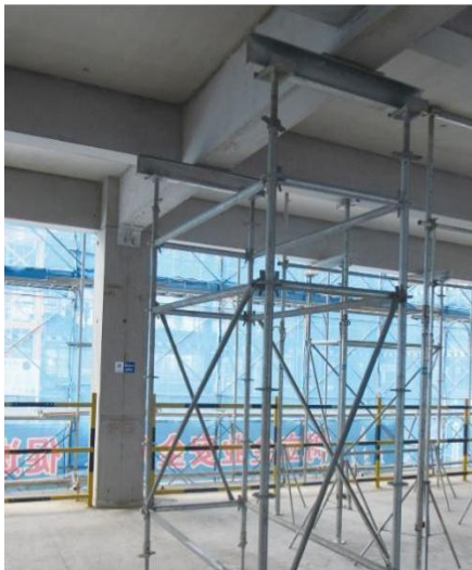
(a)主梁承插式盘扣支撑体系
