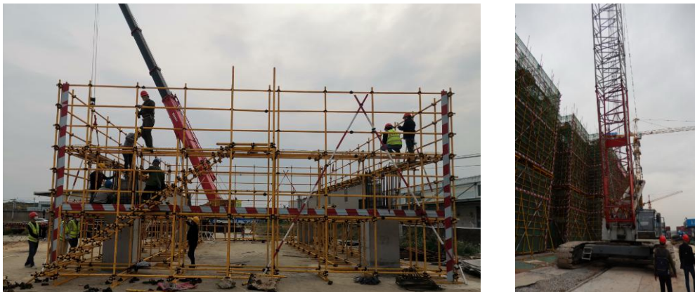
图 2 工法验证区、起重设备（QUY260 履带式起重机）
