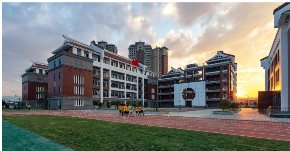
图 1 项目竣工实景
