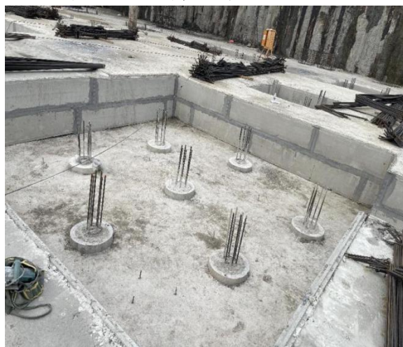
图 4 装配式承台模板实施照片
