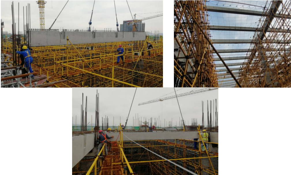
图 7 免撑免模预制体系施工实景
