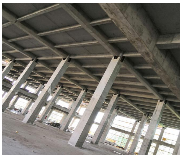
图 11 免撑免模预制楼盖体系主次梁安装完成状态
